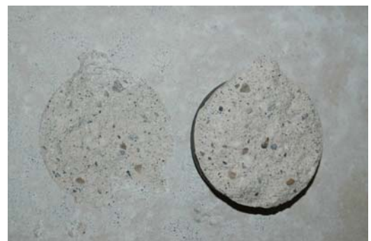
Korn am Ausriss sichtbar
